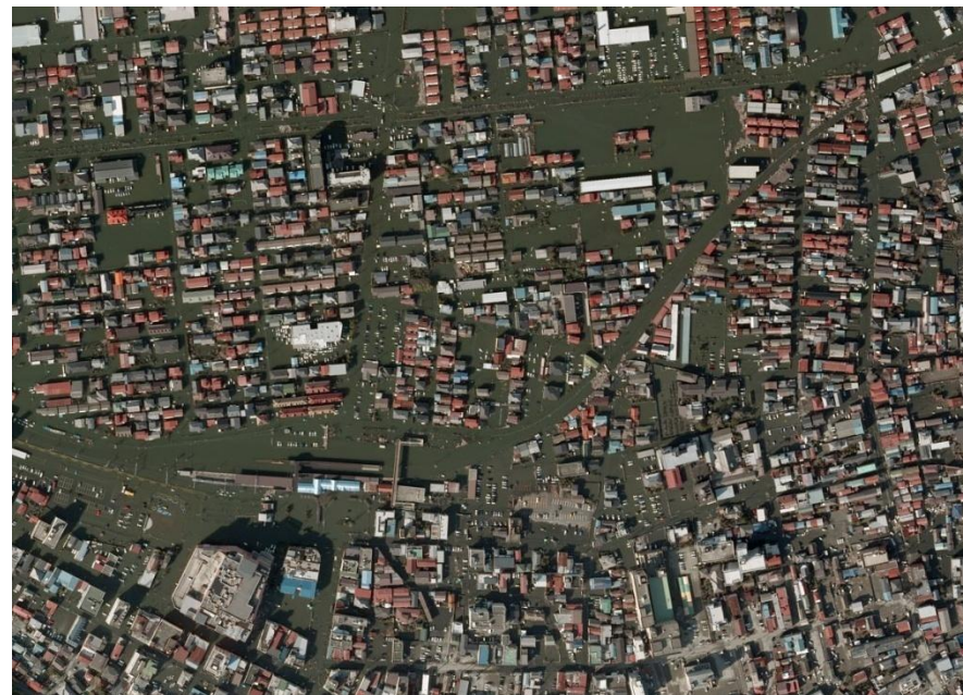
被災後(平成23年3月12日撮影)
