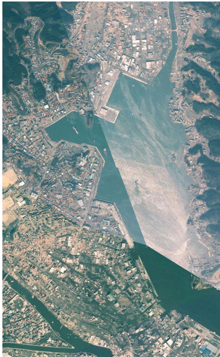
被災後(平成23年3月13日撮影)
